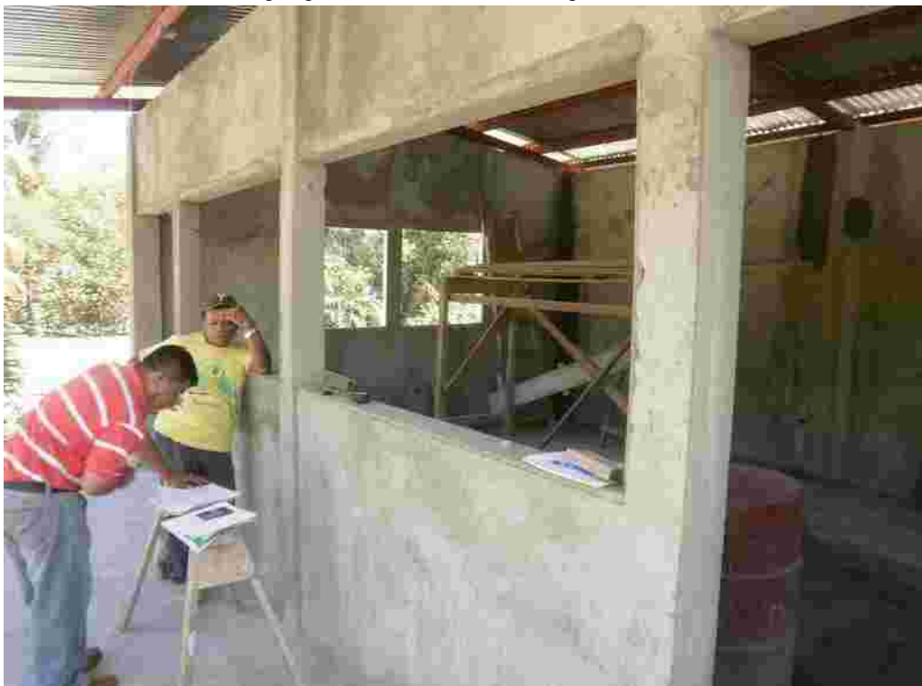
Bauleiter und Ingenieur bei der Arbeit. Im zweiten Stock.
