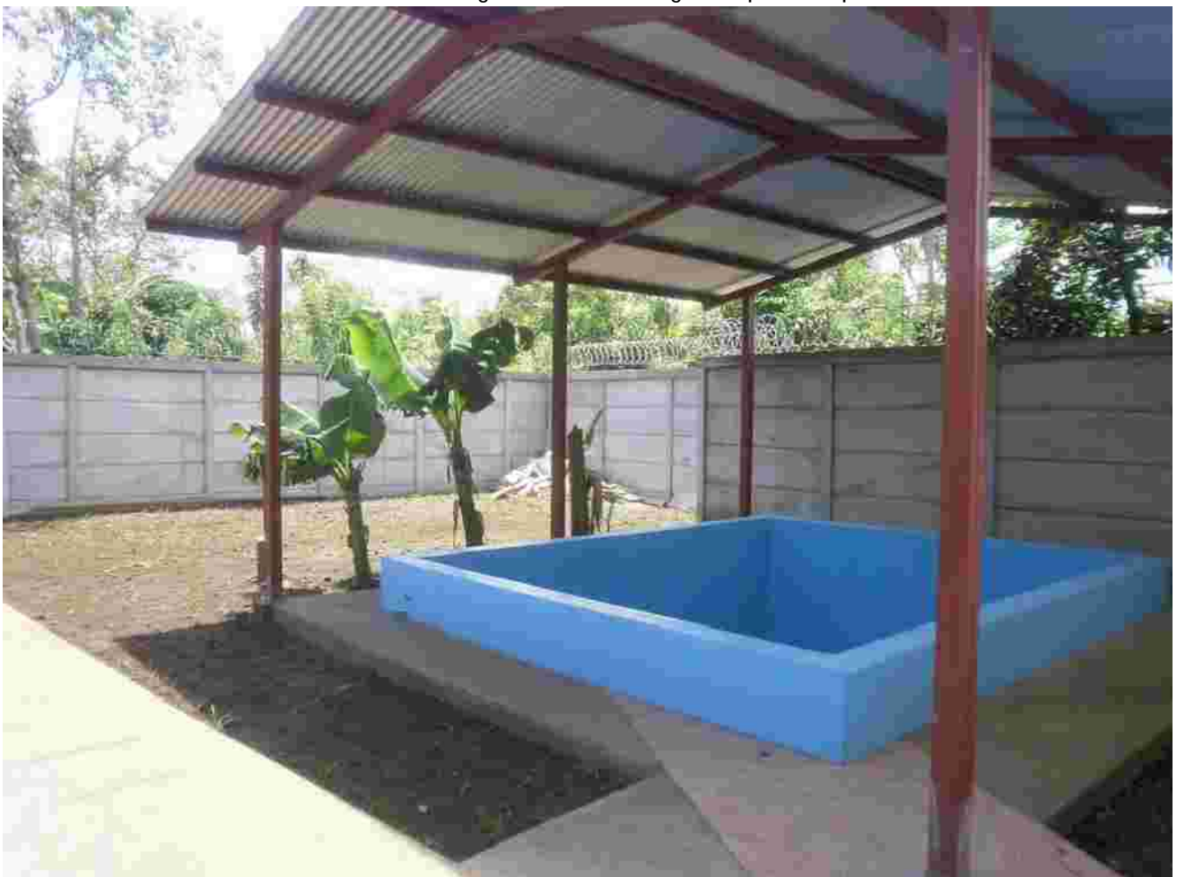
Der Hof mit dem fertigen Schwimmbad. Jetzt muss nur noch das Gras wachsen.
